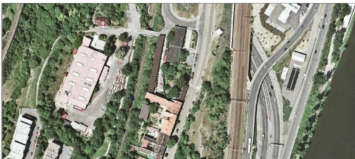
Příklad plošně významné dopravní infrastruktury. Mimoúrovňové křížení silnic a železnice.
